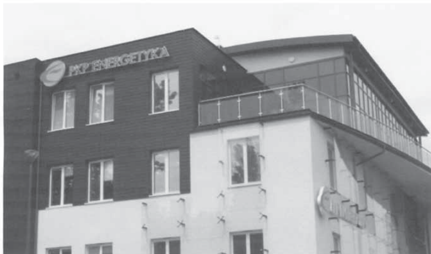
Fot. PKP Energetyka
