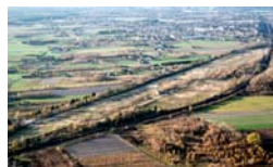
Tereny PKP S.A. w Zdunskiej Woli, na których ma zostać zbudowany terminal multimodalny
